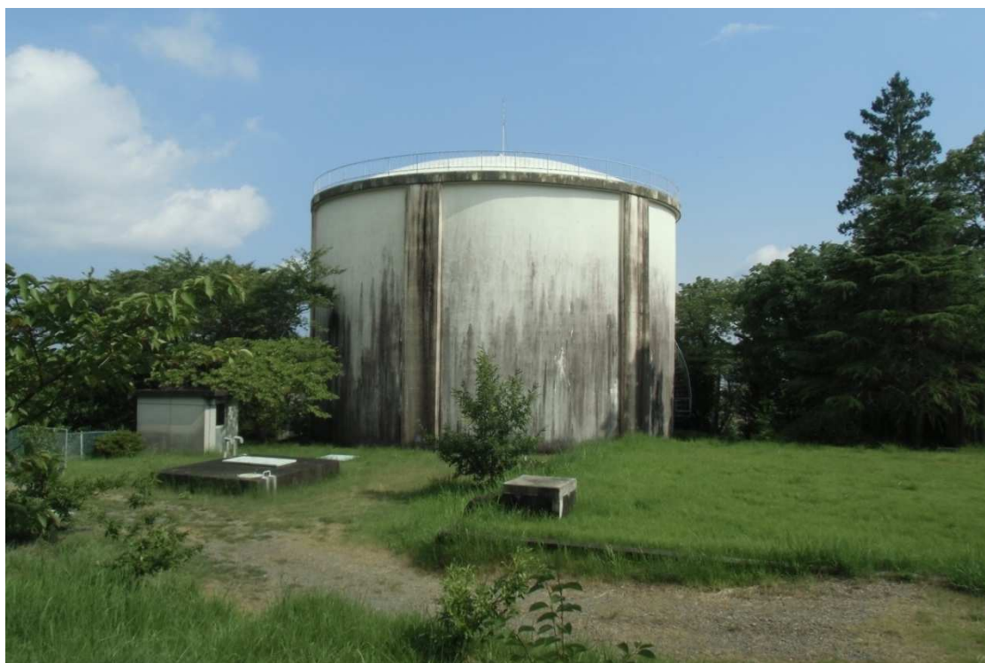
天神原配水池
