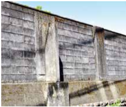
控壁や厚さ、劣化などを確認
