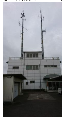
【金谷防災センター】
