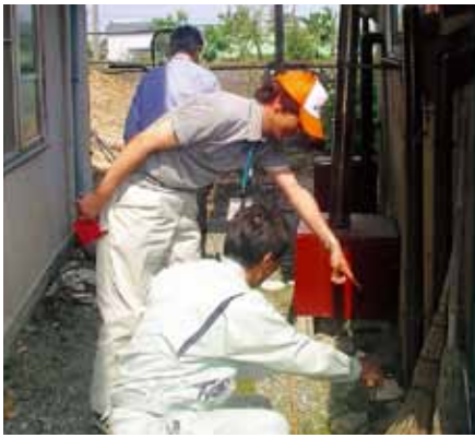
被災家屋を調査する建築住宅課職員
