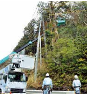
高所の樹木を伐採する作業員
