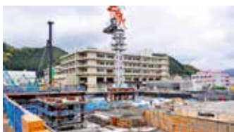
建設中の新市民病院
