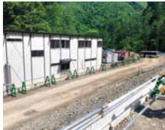
作業宿舎の工事現場
