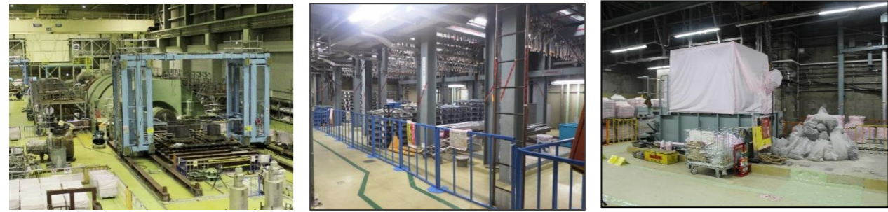
2号機 タービン・発電機の解体工事の状況 2号機 制御棒駆動水圧制御ユニットの解体工事の状況 1号機 原子炉再循環流量制御系の解体工事の状況
