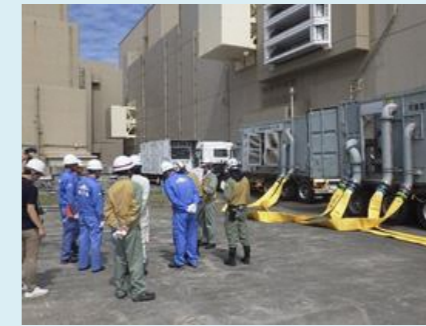
代替熱交換器用配管設置工事及び可搬設備 (代替熱交換器車) の点検の様子 (第87回)
