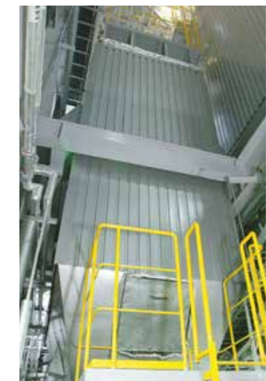
■脱硝装置 触媒により、ダイオキシン類や窒素酸化物を分解し、無害化します。 De-NOx system Catalytic agents are used to break down dioxins, NOx compounds and other pollutants, rendering them harmless.
