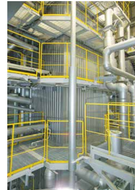
■ボイラ 余熱利用に必要な温水をつくります。 Boiler Waste heat is used to boil water.
