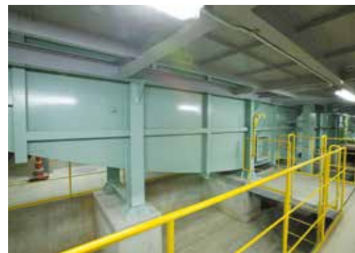
■水砕ピット 溶融炉下部より出湯した溶融物を急速冷却します。 Quenching tank Melt tapped from the base of the furnace is quenched here.
