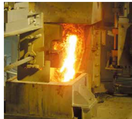
■出湯口 約1時間に1回、溶融炉下部出湯口より出湯します。 Melt tapping Melt is tapped from the base of the furnace about once an hour.
