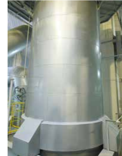
■減温塔 排ガスの温度を160℃まで下げます。 Quenching chamber Flue-gas is cooled to 160°C.
