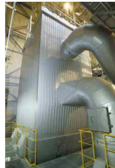
■集じん器 排ガスに含まれる細かい塵などを内部のろ布で捕集します。 Bag filter This fabric filter captures the fly ash contained in flue-gas.
