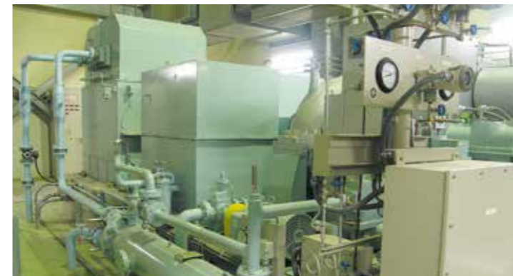
■蒸気タービン発電機 ボイラで作られた蒸気を利用して発電し、施設内の電力を賄うとともに余剰電力については施設外に売電します。 Steam turbine generator This equipment generates electricity utilizing the steam generated by the boiler to provide electricity for the plant and sells surplus electricity to the buyer outside the plant.
