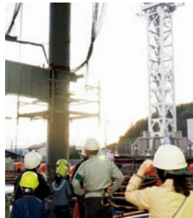
病院建設現場の親子見学会
