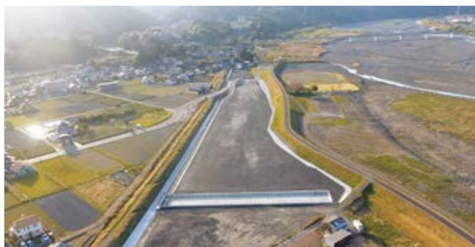
堤間地区工業用地建設現場
