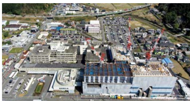
新病院「島田市立総合医療センター」建設現場
