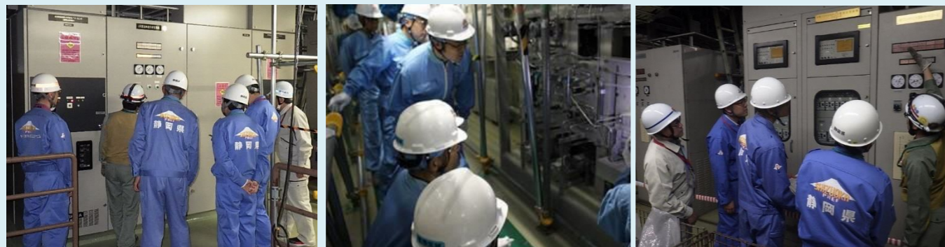
緊急時原子炉充電器現場据付状況確認の様子(第90回)
