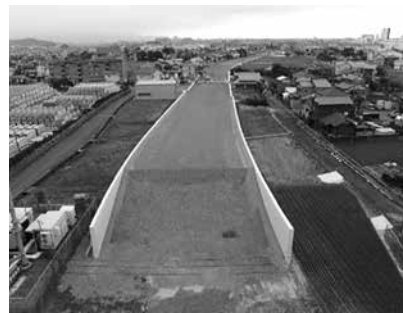
整備が進む東町御請線
