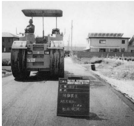
溶融スラグを混ぜたアスファルト舗装
