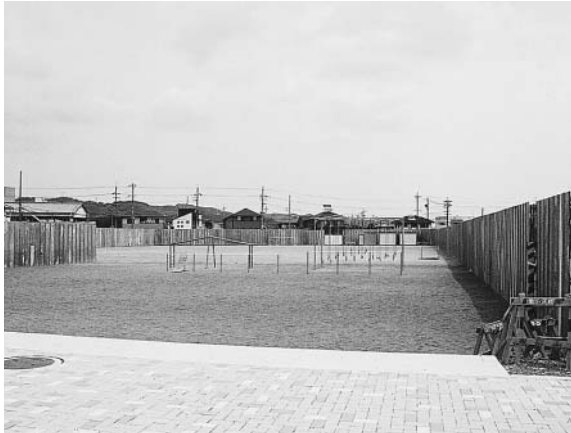
工事中の六合小学校グラウンド
