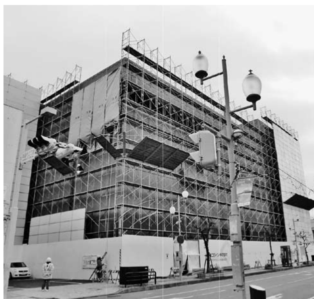
島田ショッピングビル解体現場
