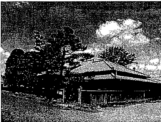
旧桜井家住宅（外観）
