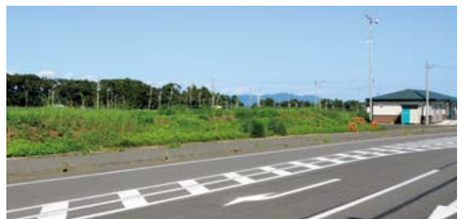
拡幅した市道と移設した「かたくり会館」
