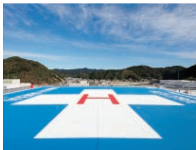
屋上ヘリポート
