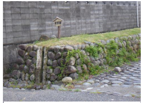
善太夫嶋堤（せぎ跡）
