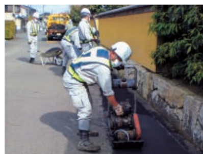
道路を修繕する作業員
