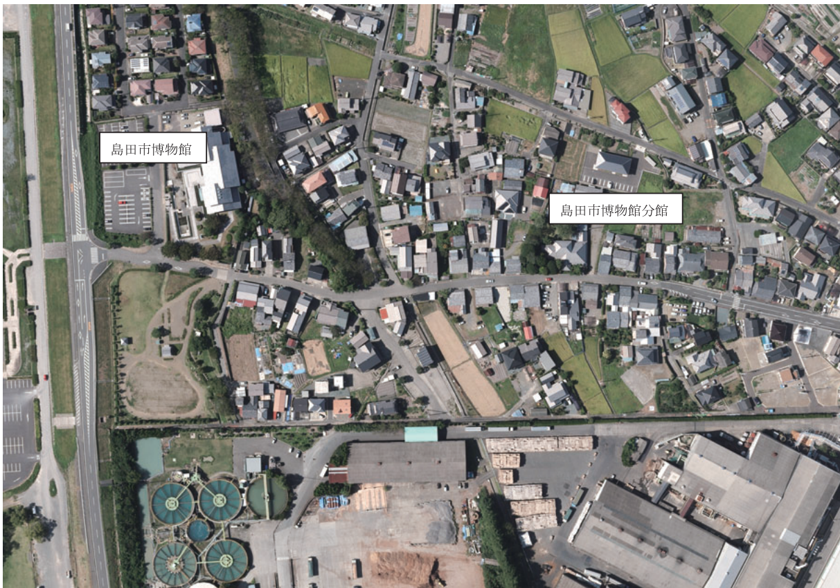
写3-1 史跡指定地及び周辺の航空写真 (平成25年撮影)
