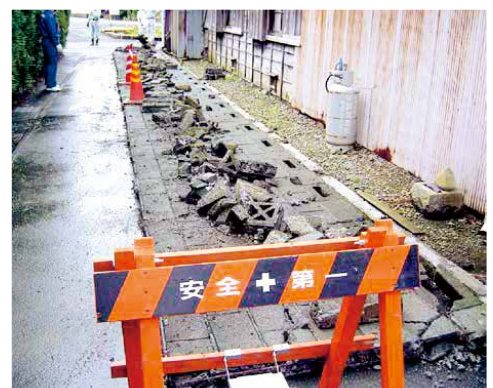
倒壊したブロック塀(提供:静岡県)
