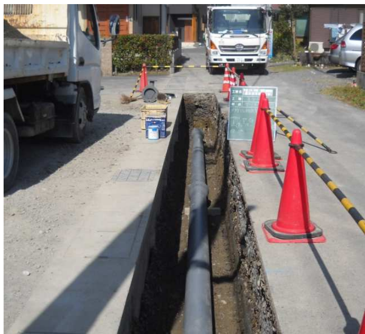
管路の更新の様子
