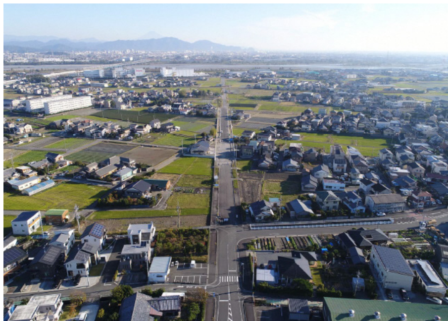
▲ 工事中の色尾大柳線
