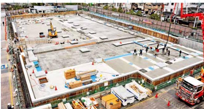
建設工事が進む市役所新庁舎
