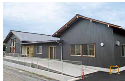
完成した向谷町自治会館「木の香」
