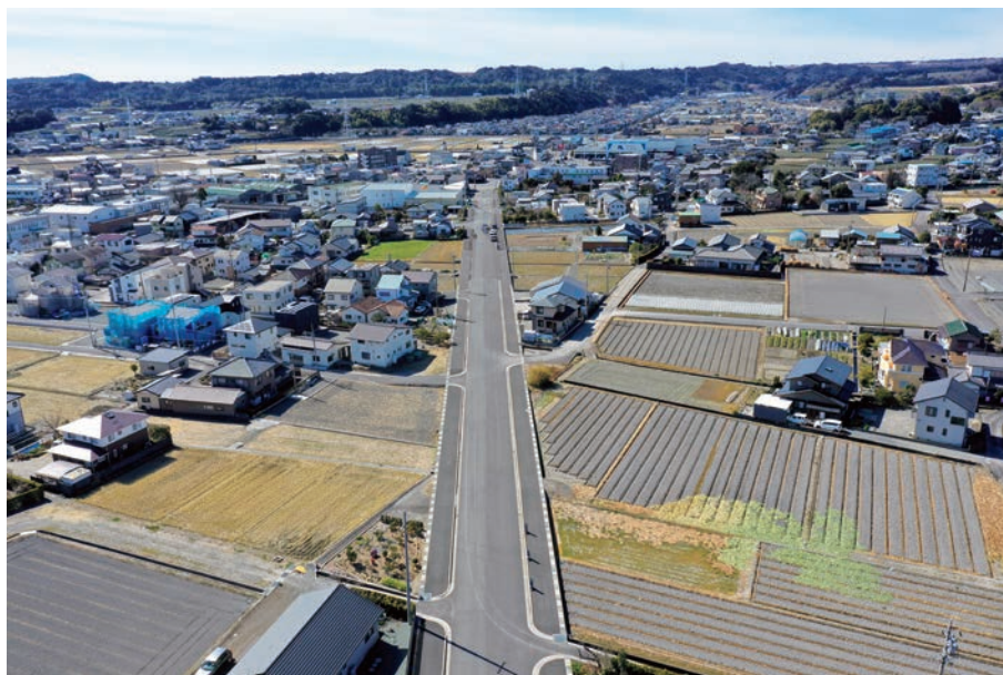
▲ 工事中的色尾大柳線
