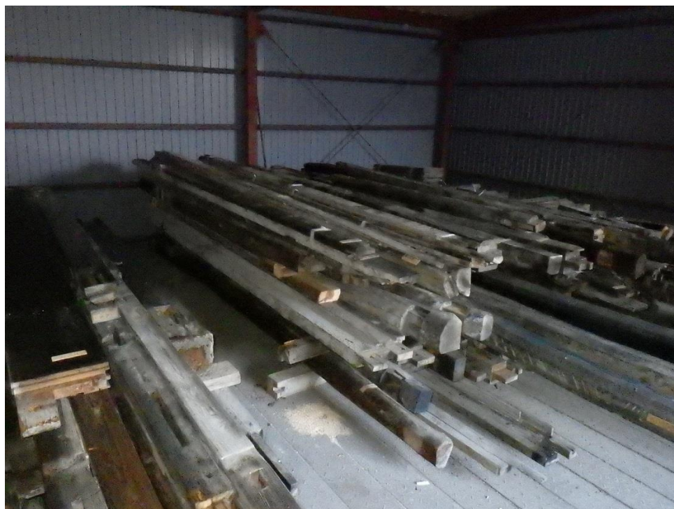
解体後の立合宿部材
