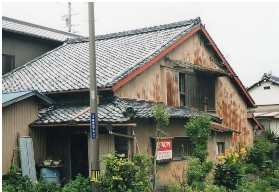
解体前の旧立合宿
