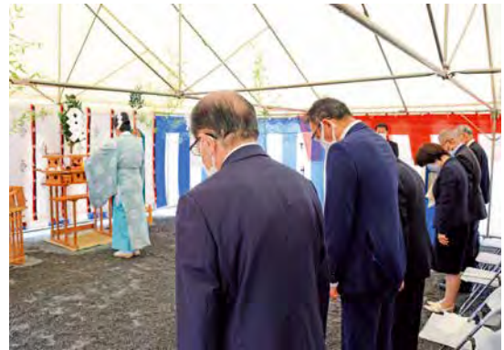
工事の安全を願う関係者ら
