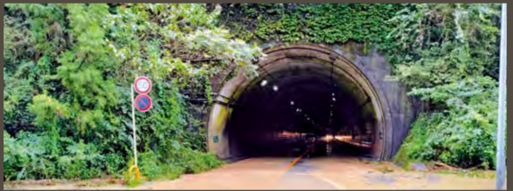
大雨により冠水した新鍋島トンネル
