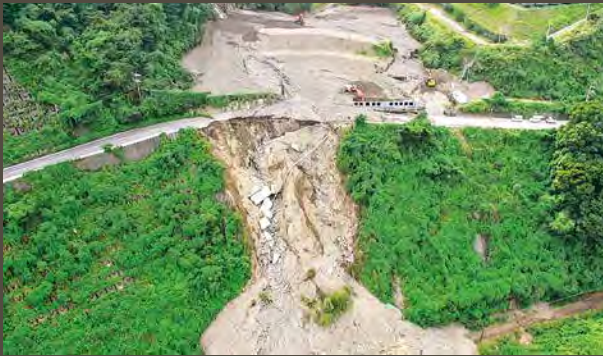
土砂流出により、通行止めとなった国道473号と大井川鐵道
