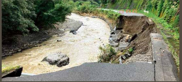
伊久美川の増水により、崩落した県道蔵田島田線
