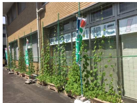
【グリーンカーテン（川根庁舎）】
