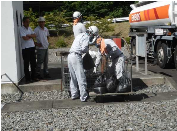
(土嚢による屋外流出防止対策)
