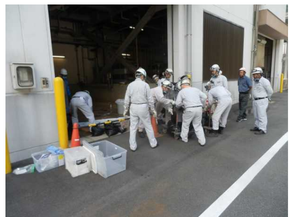
(吸着マットの敷設)
