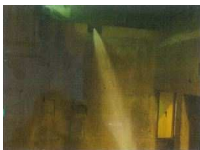
【放水銃による消火】
