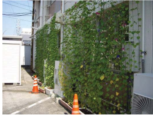
建物南側にグリーンカーテンを設置し、エアコン効率をあげています（第二庁舎）
