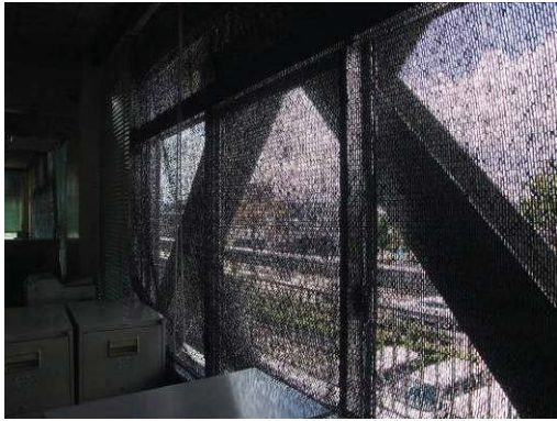
西側の窓に日よけを設置し、エアコン効率をあげています（本庁舎）
