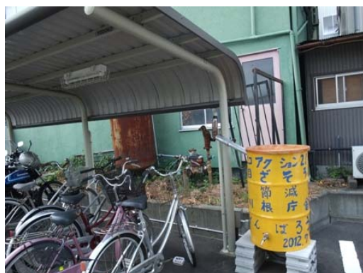
自転車置場屋根の雨水タンクを増設し、グリーンカーテン育成に使用するとともに、節電をPRしています。(川根支所)
