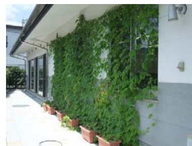
グリーンカーテンを設置し、エアコン効率を上げています。(各支所)。
