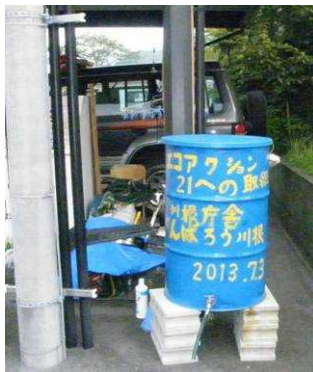
自転車置き場の屋根の雨水をタンクに集め、グリーンカーテンの育成に利用しています。
