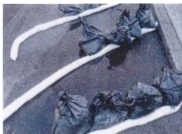
【土嚢袋・オイルフェンス設置】
