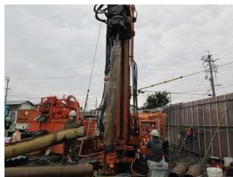
【地中熱利用のための井戸掘削工事】
