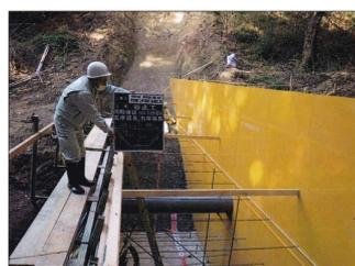
治山復旧工事 残存型枠工
