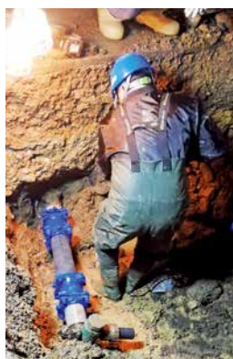
夜間の水道管工事
