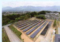
リユース品を使用した発電所
