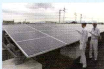
太陽光発電設備の検査の様子
