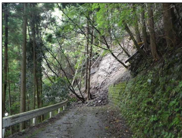
【令和元年台風19号による家山地区の土砂災害】
