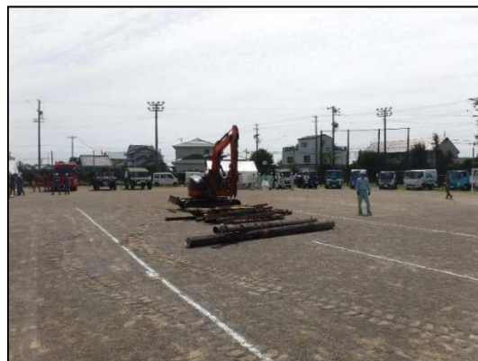
【平成 29 年度 総合防災訓練（道路啓開訓練）】
