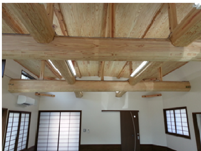
写真 1-1-3 木造消防詰め所(第 15 分)
