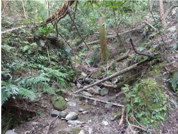
写真Ⅲ.2.23 移植後 20 年のB地区イワタバコ移植地 沢部の崩壊が著しい (撮影:2020年4月8日)
