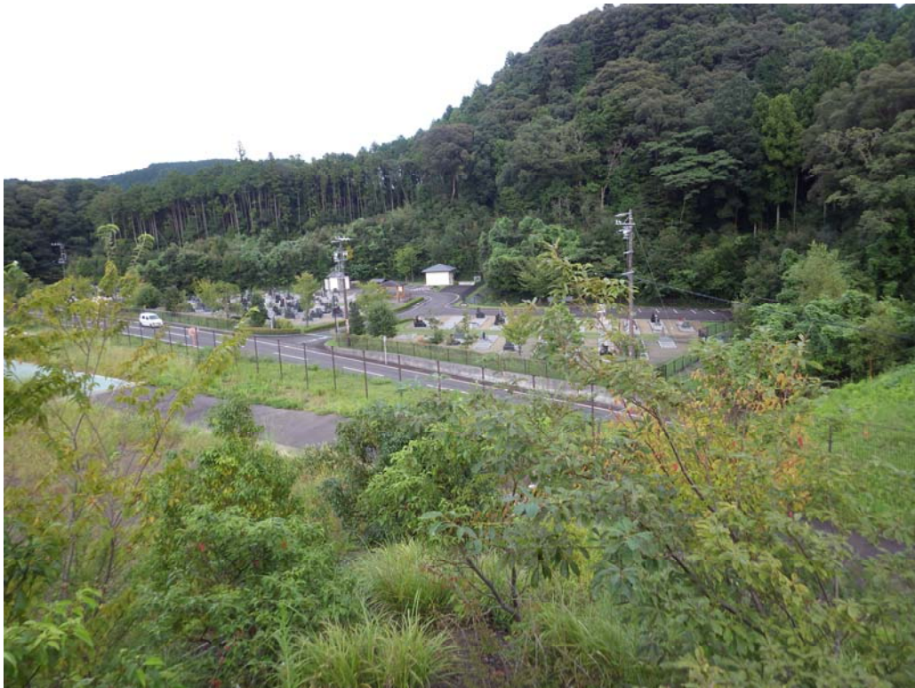
市立霊園(第1工区:手前、第2工区奥)
