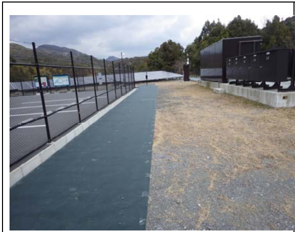
ソーラー施設内の防草シートの設置(2016.2.24)
