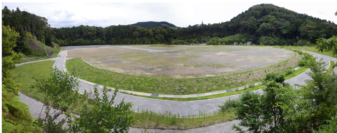
多目的スポーツ・レクリエーション広場(工事中) 2019.6.14
