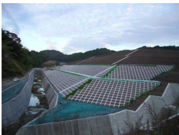
長大のり面造成中 2004年11月24日
