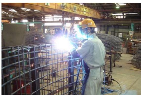
炭酸ガス溶接による鉄筋籠組立
