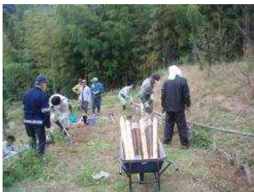
管理道の修復作業
